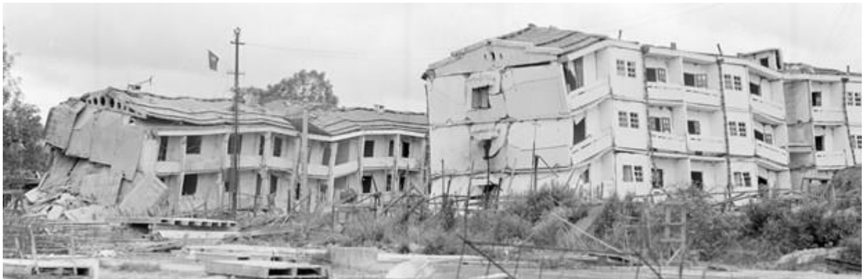
Khu nhà lắp ghép 4 tầng của cán bộ, công nhân thị xã Lào Cai, tỉnh Hoàng Liên Sơn (nay thuộc tỉnh Lào Cai) bị địch dùng mìn đánh phá. (Ảnh: Phùng Triệu/TTXVN)
